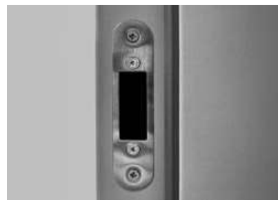
háč magnetického zámku v zárubni
